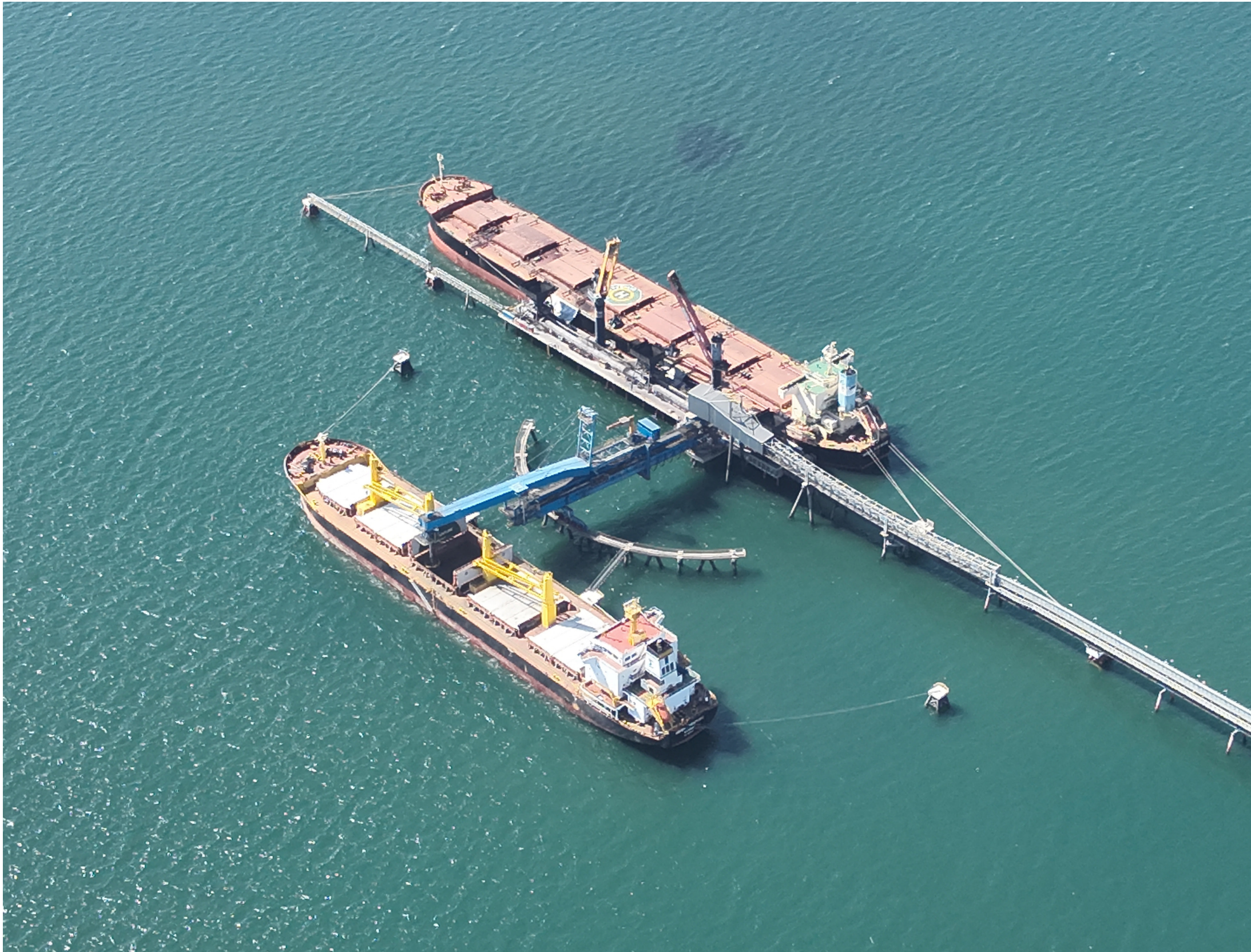
Shiploader radial del nuevo terminal de embarque automatizado de graneles
